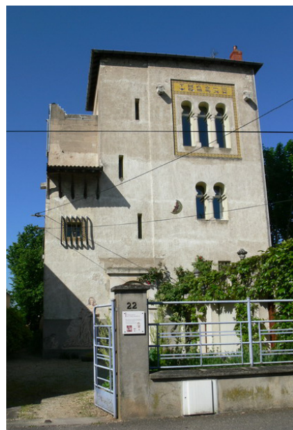
Façade principale, rue Ranchot
